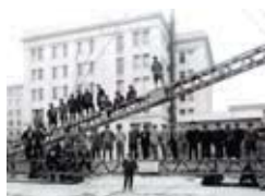
技術者と職人が記念撮影(三井本館解体工事現場、大正15年、三井文庫蔵)
