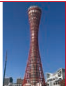
神戸ポートタワー
